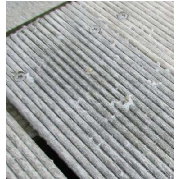
8.4 Een geribbeld plankprofiel heeft de neiging tot opeenhoping van vezels
