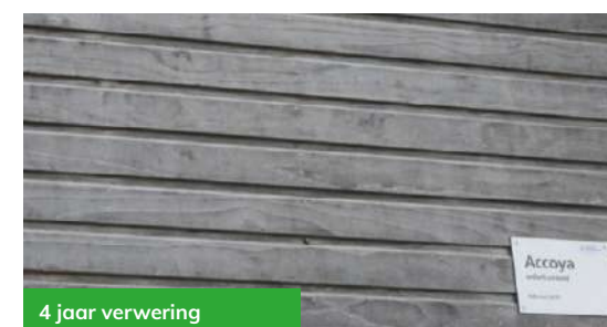
GEVELBEKLEDING KANTOOR, VROOMSHOOP, NEDERLAND
