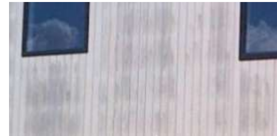
8.5 Een woningbouwproject in Nieuw-Zeeland met een zeer duidelijk silhouet van het achterliggende stijl- en regelwerk in het bekledingsoppervlak
